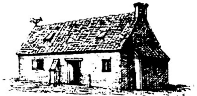
Fig. 1. — Vue d'une maison de cultivateur.
